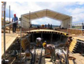
Viadukt Rondo Slowenien
