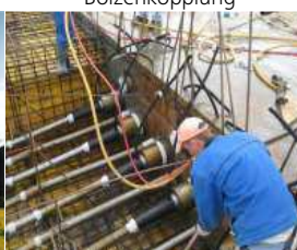
Feste Koppelstellen Bolzenkopplung
