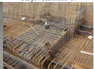
Endverankerungen ausgekrenzte Lisenen
