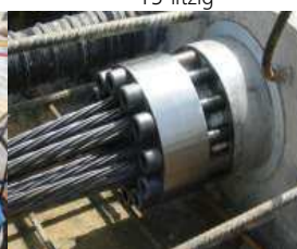
Koppelstelle mit Bolzen 15-litzig
