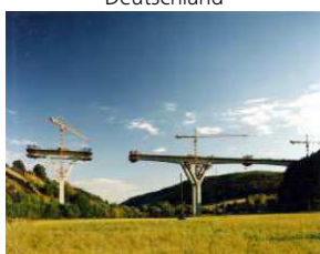
Talbrücke Zahme Gera Deutschland
