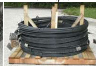
Spannbänder 4-litzig, fertig für Transport
