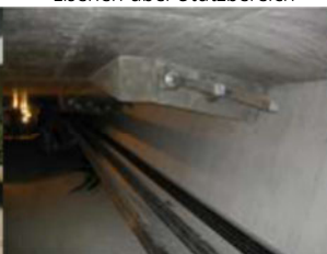
Endverankerungen Lisenen über Stützbereich
