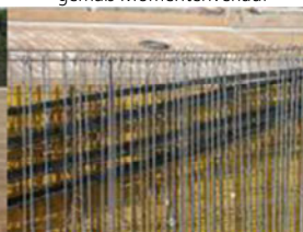
Längsvorspannung, Lage Steg gemäß Momentenverlauf
